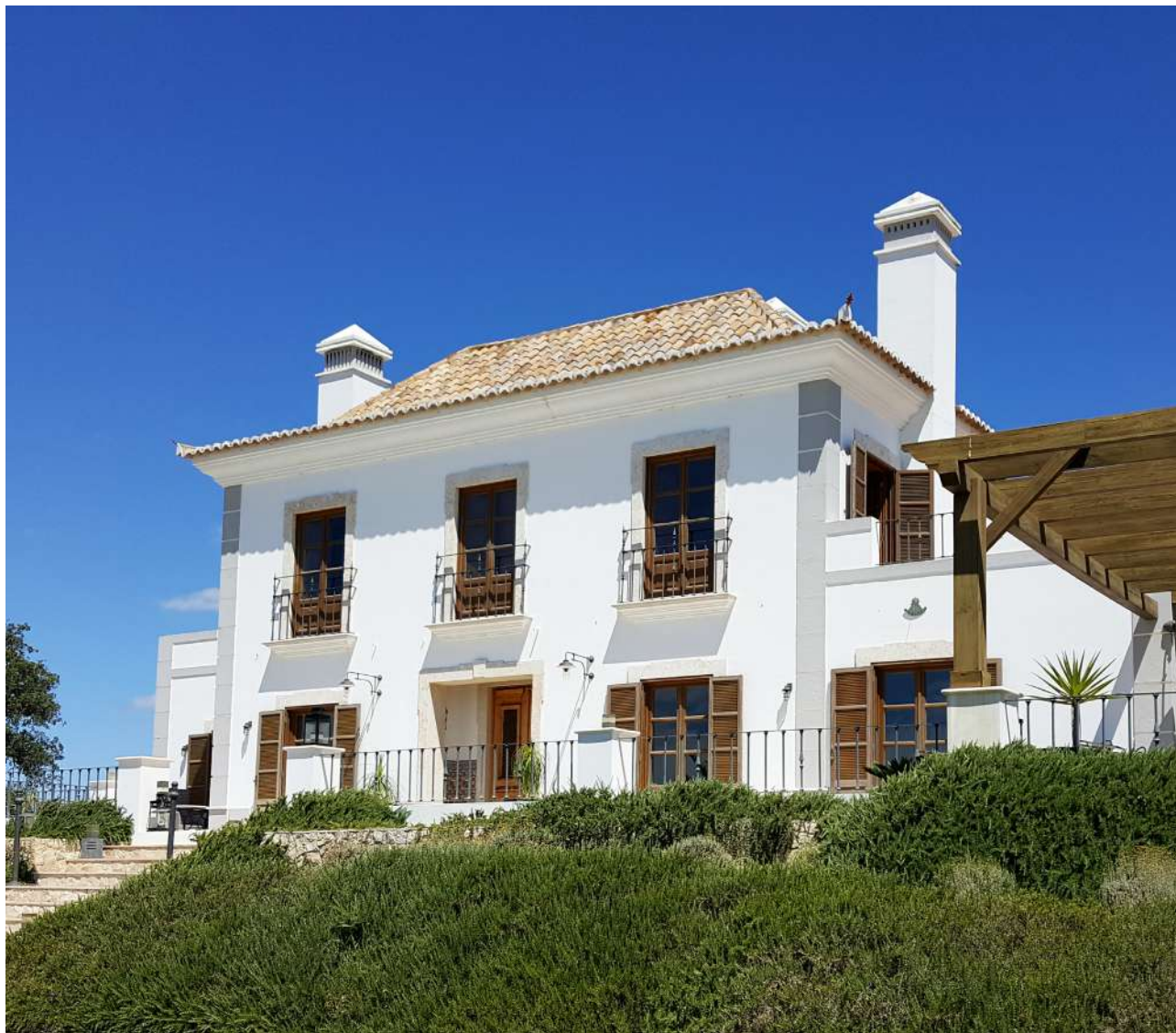
Rénovation complète de la maison, avec conservation du style traditionnel de fenêtres, portes-fenêtres et volets en chêne. Full house window replacement, keeping the traditional style of oak windows, exterior doors and shutters.
