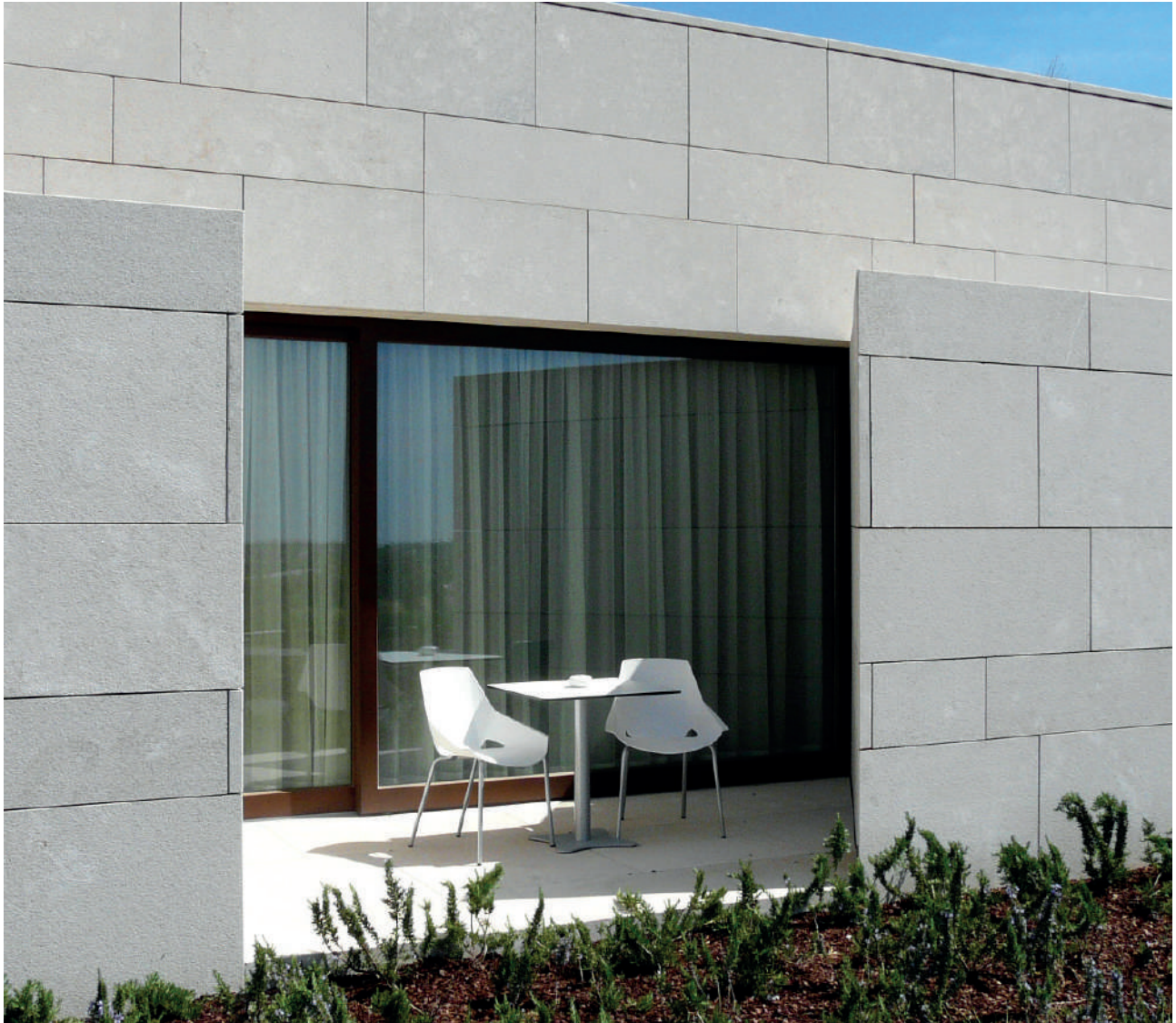
Porte levante-coulissante dans la partie moderne du Palácio de Estoi. Lift and slide door in the modern part of Palácio de Estoi.
